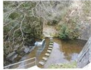
E34 橋詰発電所導水路
