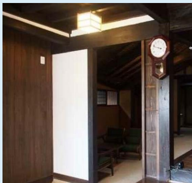
荒壁パネルによる補強壁を設置 文化庁『伝統的建造物群の耐震対策の手引』より
