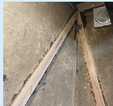
筋交いによる補強（保存地区内）
