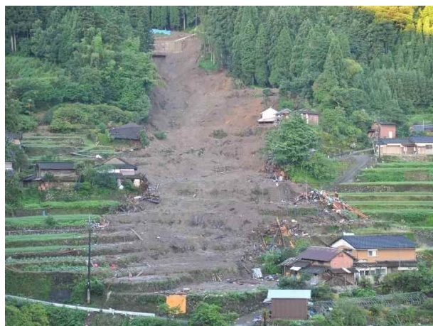
[平成24(2012)年九州北部豪雨でのうきは市山間部の被害]
