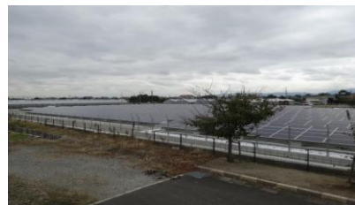
吉井浄化センター
