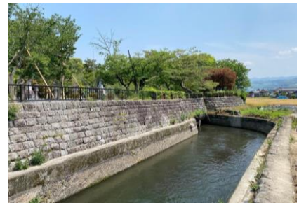
大石・長野水道（長野水神社下流）
