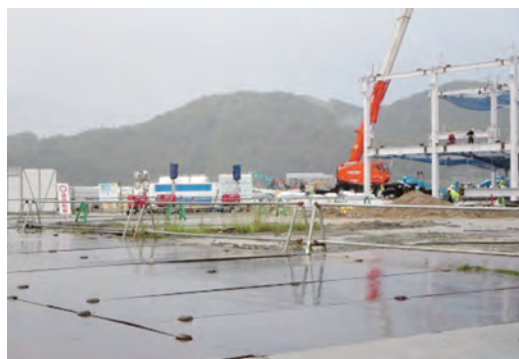
三春工業団地に建設中の進出企業（ROKI）
