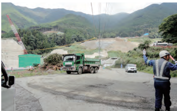
小石原川ダムの付帯工事現場
