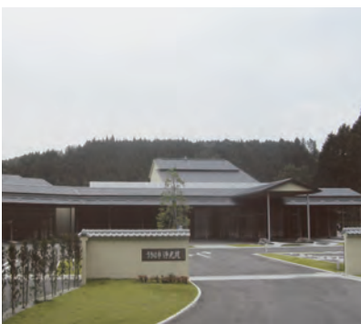
厳粛で心情に配慮した施設「浄光苑」
