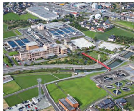
福岡県南広域水道企業団の全景(久留米市荒木町)
