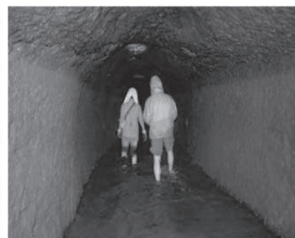
将棋駒の形に掘削された 隧道内部の様子
