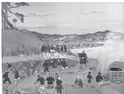
水道工事の起工
