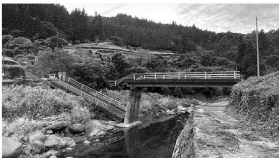
▲ 令和2年7月豪雨で被災した箇所を早期復旧に向け災害復旧工事を実施しています。
