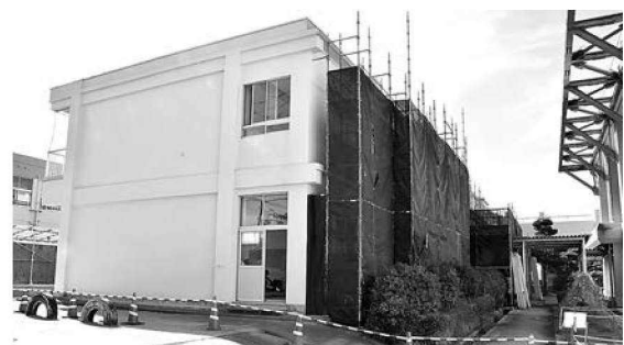
▲ 小学校の統廃合に伴い、学習環境改善のため御幸小学校中校舎を改修工事しています。
