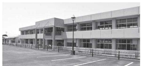
▲小学校の統廃合に伴う、御幸小学校南校舎の大規模工事を行い、学習環境の改善を進めました。
