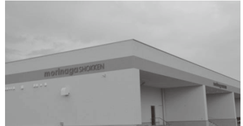
▲ 間もなく操業を開始する森永食研株式会社うきは工場(三春工業団地)
