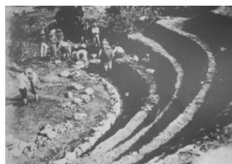
▲ 円形劇場の建設作業
