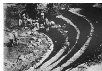
▲ 円形劇場の建設作業
