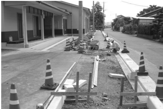
▲コミュニティセンター前の歩道等整備工事
