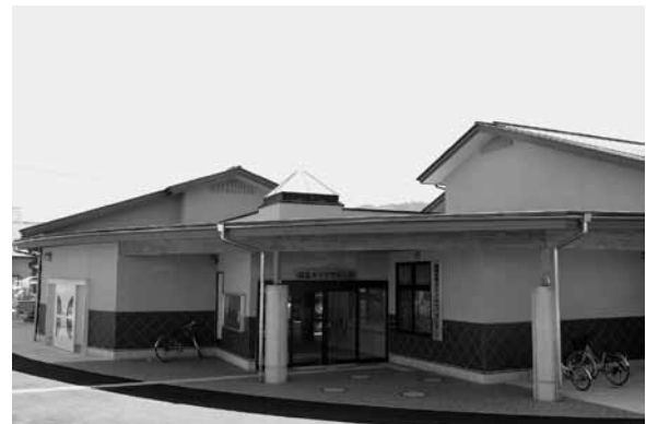
協働のまちづくりの拠点施設として、福富コミュニティセンターを整備
