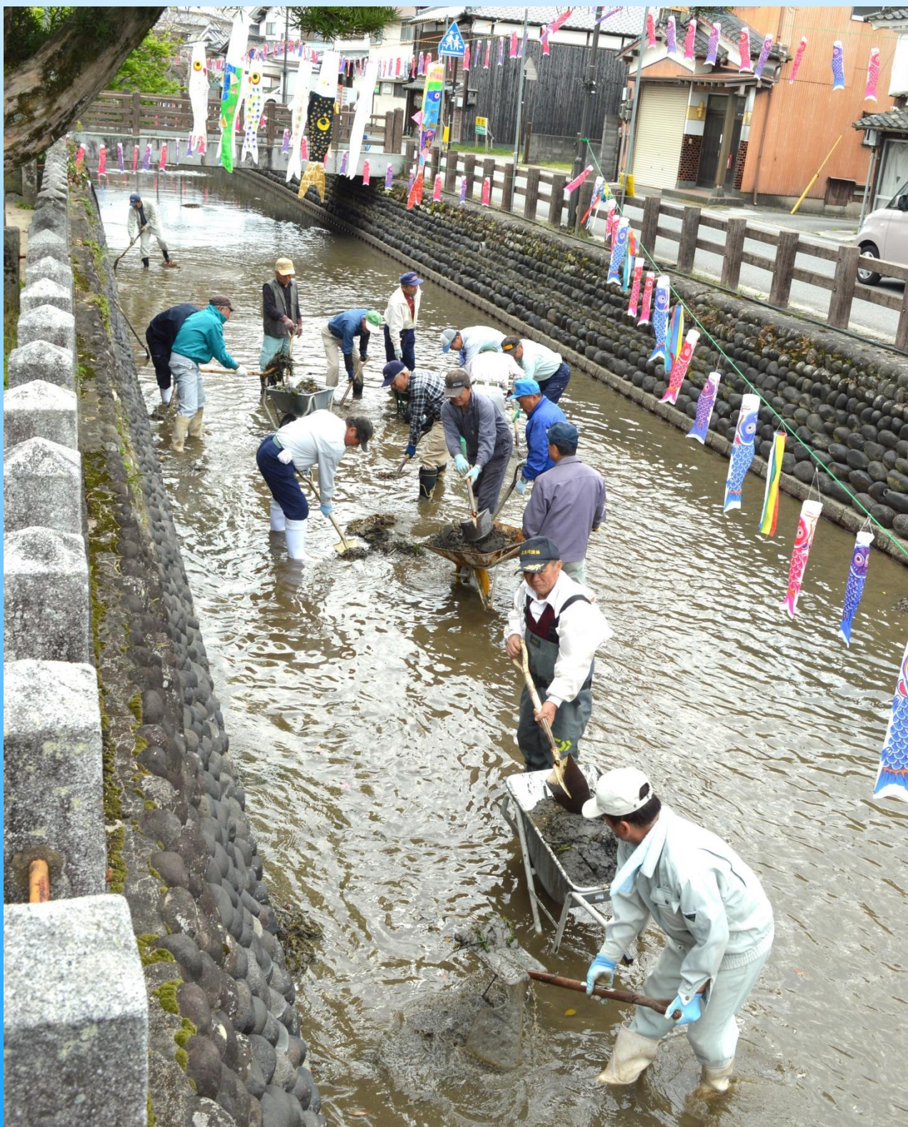
大石堰土地改良区関係者による浚渫作業(4月21日、吉井町の祇園神社付近の支流・南新川)
