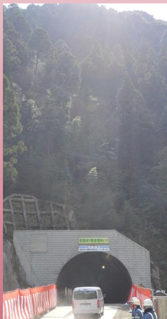
▲ 浮羽町側の坑口
