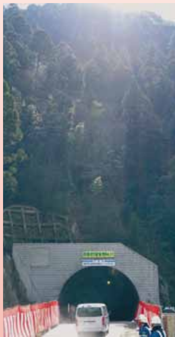
▲ 浮羽町側の坑口
