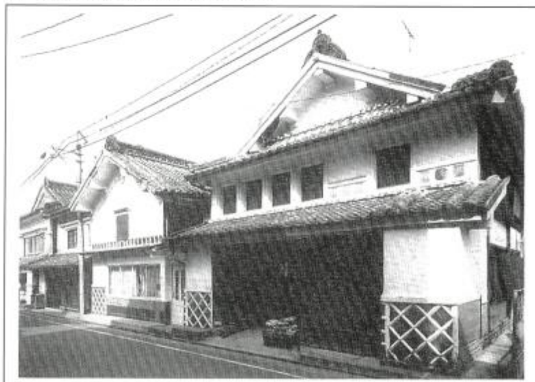
図 防火性能の高い「第一種土蔵造り」
