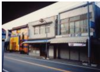
↑ 国道 210 号南側現況写真
