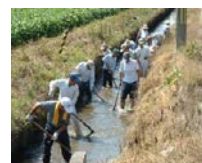
水路の泥上げ
