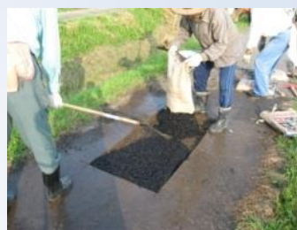
農道の部分補修
