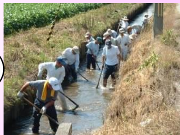
水路の泥上げ
