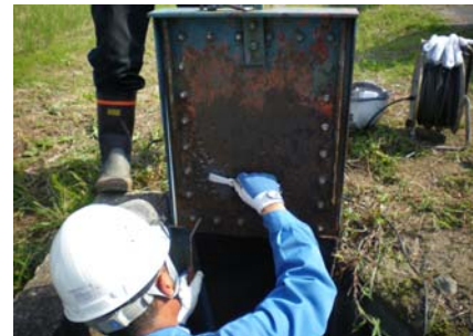
ゲートの補修状況
