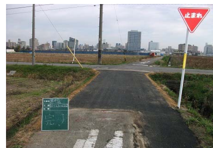
アスファルト舗装の打換え
