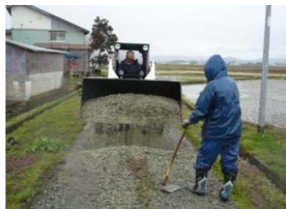
砂利の敷き均し
