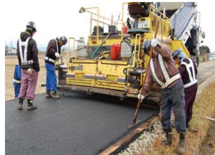
アスファルト舗装状況
