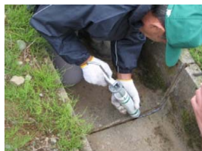
シーリング材充填
