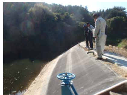
遮水シートの設置
