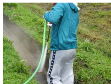
高圧洗浄機による 水路内の清掃
