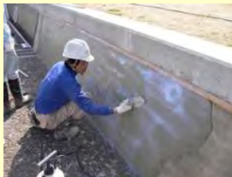
コーティング作業の状況
