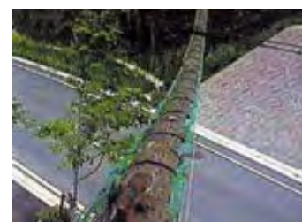
橋梁設置例 （出典：清水建設）
