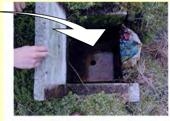
排水調整板設置状況
