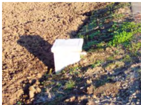
傾いた給水栓ボックス
