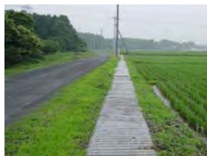
水路へのコンクリート蓋の設置
