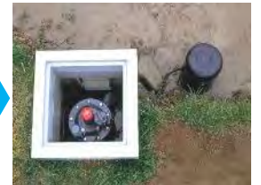
給水栓の自動化へ改良
