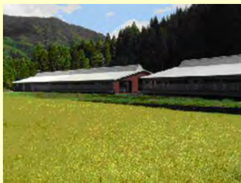
たい肥プラントの外観
