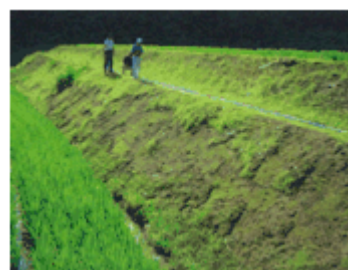
小段が設置されている法面
