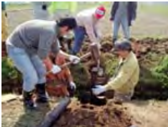
魚道の設置状況
