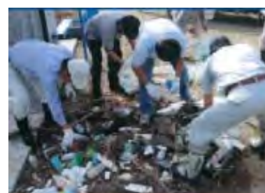
ゴミ・土砂の除去状況
