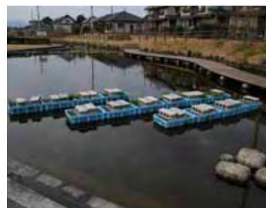
木炭浄化（接触酸化法の一つ）
