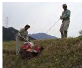
小段設置状況（掘削）
