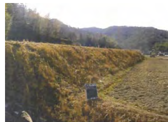
高低差のある畦畔法面
