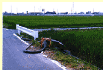
ポンプアップ状況
