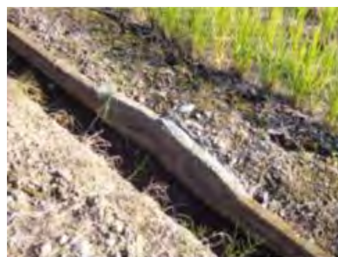
改修したU字溝
