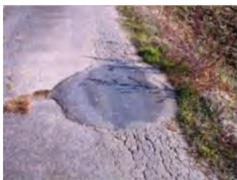
穴・窪みの補修（路面） （アスファルト合材による補修）
