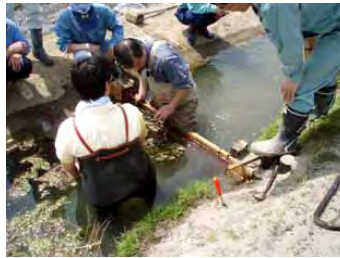
魚道の設置状況（堰板の設置）
