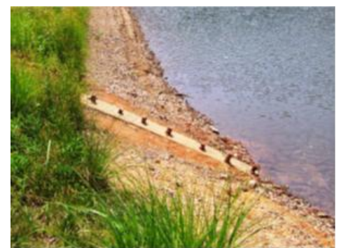
斜樋と取水栓
