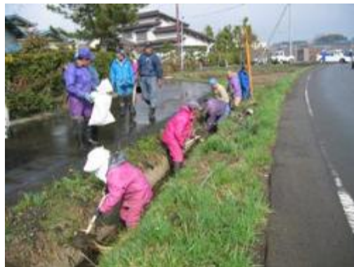
側溝の泥上げ
