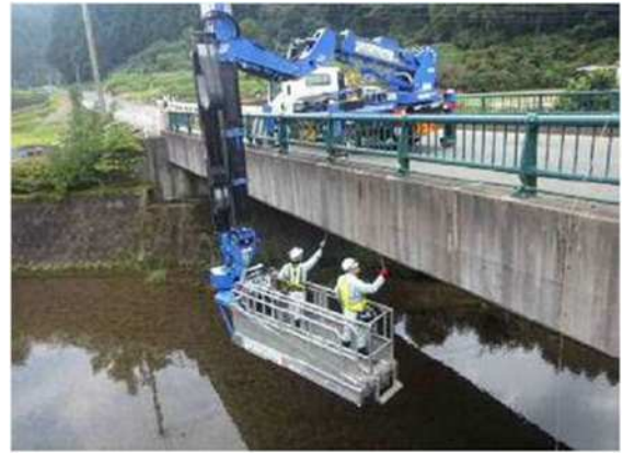
[ 橋梁点検車による定点検状況 ]
