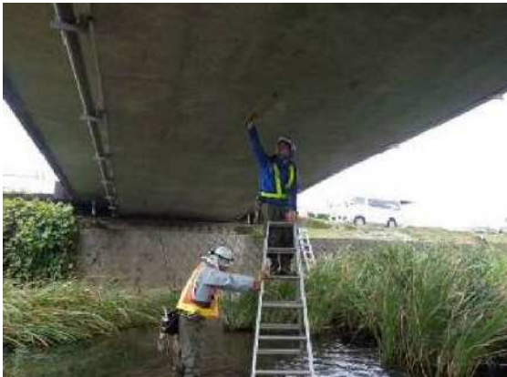
[ 梯子による定期点検状況 ]
