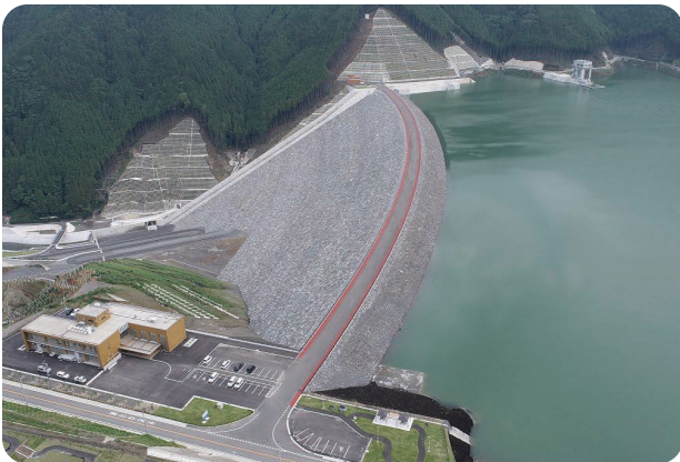
(小石原川ダム)
