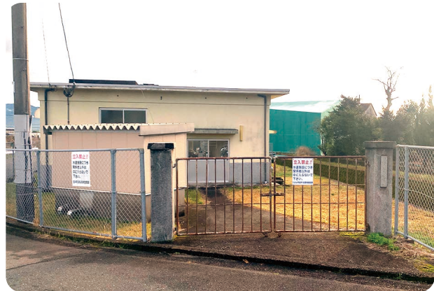
(富永簡易水道施設)
