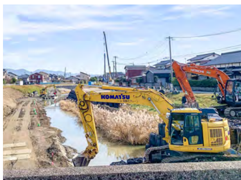
災害復旧助成事業が進む巨瀬川
