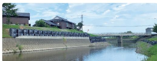
応急処置のできた巨瀬川岩光橋の兩岸
