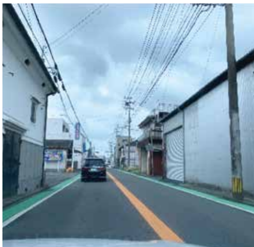
210号線通学路の カラー舗装が東半分完了
