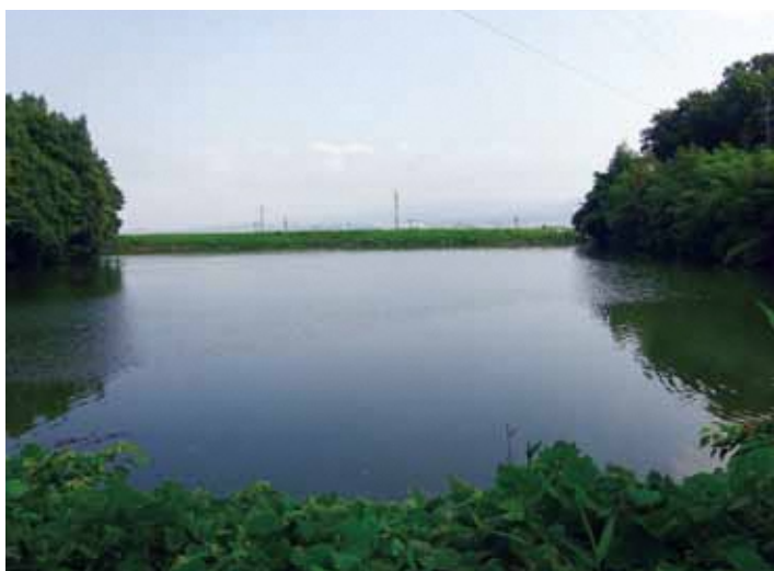
改修が急がれる老朽化したため池
