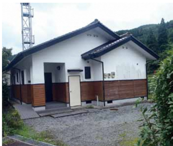
利用が進まない山間部の市営住宅
