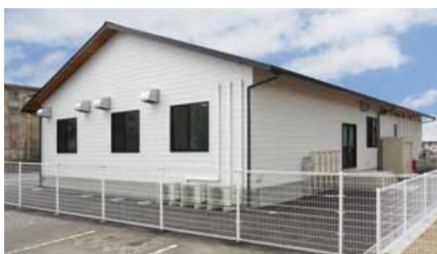
完成した6次産業化支援センター
