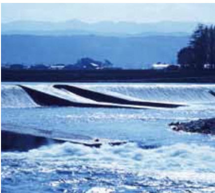
筑後川から取水の大石堰
