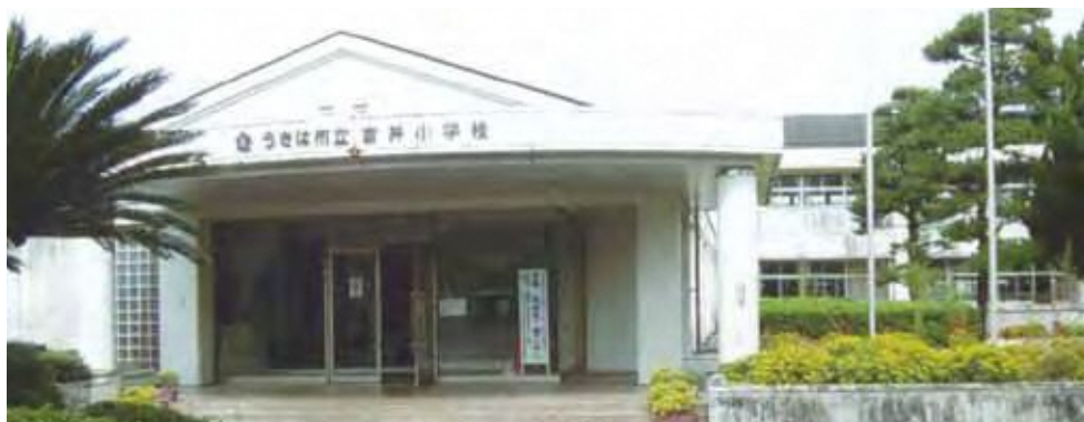
老朽化が進む吉井小学校
