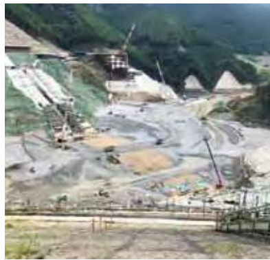
小石原川ダム工事状況
