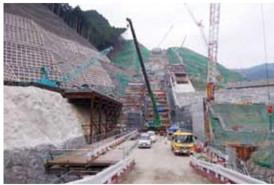
小石原川ダム進捗状況
