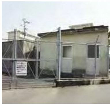
ビレッジハウス給水施設
