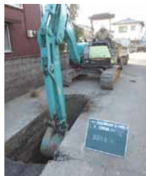
下水道工事掘削状況
