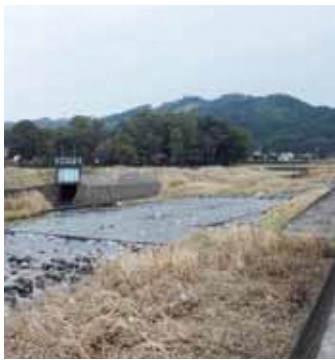
赤尾川から限上川への暗渠排水口
