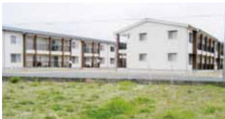
従来の方式で新築された市営住宅
