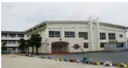
地番の無い河川敷に建ってる福富小体育館
