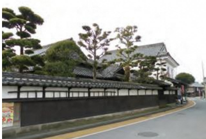
「居蔵の館」(旧・松田邸)農産物加工で富を成したことを象徴する住宅と蔵が同居する豪邸。重要伝統的建造物群保存地区内のひとつ。吉井町
