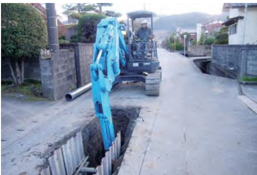
下水道管を埋設するための開削工事現場
