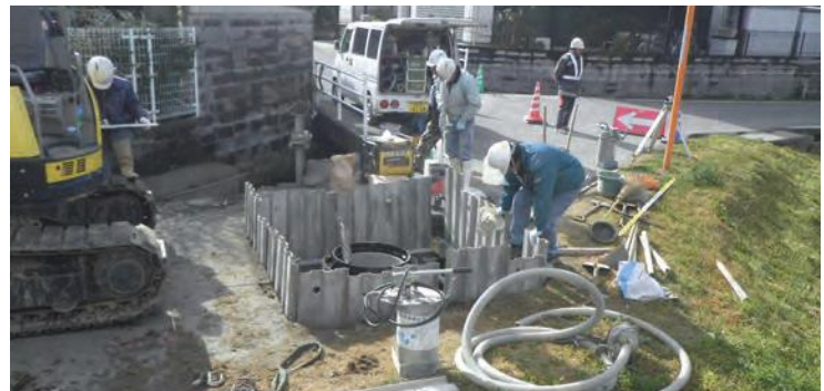
下水道拡張工事の現場状況
