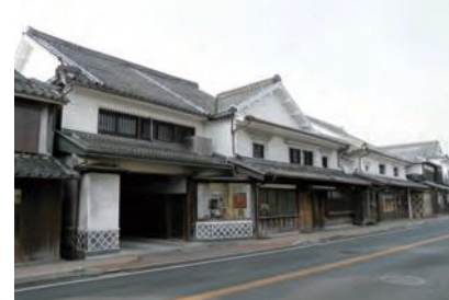
「矢野家」酒造業で富を成した重厚な建物。この地区の象徴でもある。重要伝統的建造物群保存地区内のひとつ。吉井町
