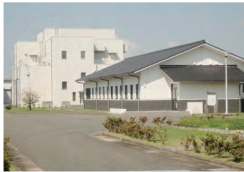
5億円以上を繰入している下水道浄化センター
