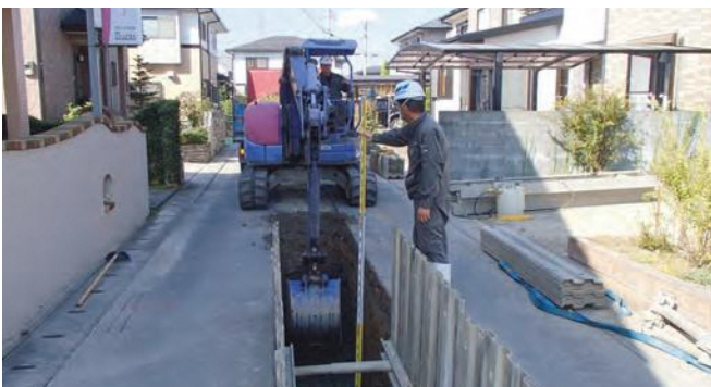
進められている下水道工事
