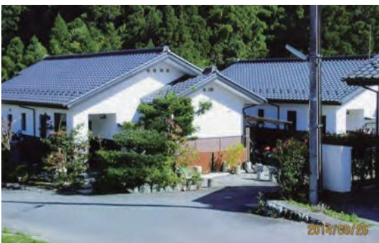
姫治地区の市営住宅
