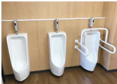
新しく改修されたトイレ
