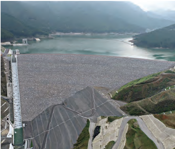
小石原川ダム
