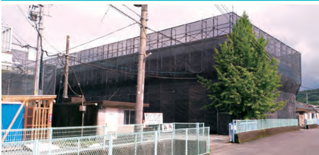
御幸小学校北校舎大規模改造工事
