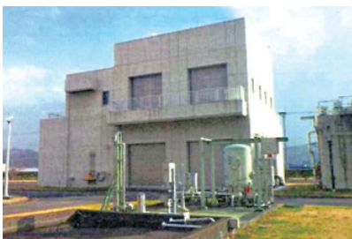
汚泥脱水棟（浮羽浄化センター）
