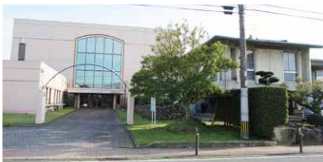
かわせみホール&浮羽歴史民俗資料館
