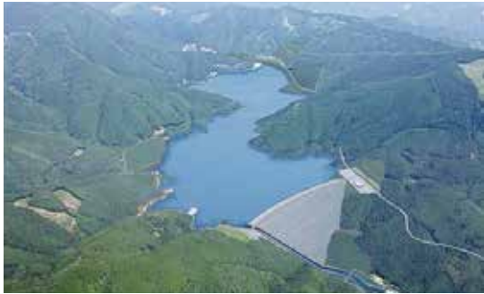
完成間近な小石原川ダム
