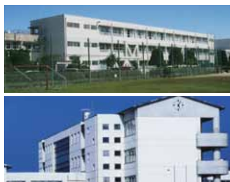
エアコンが設置される浮羽・吉井中学校
