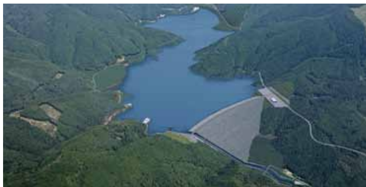
小石原ダム完成イメージ
