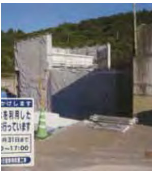
工事中の藤波ダム小水力発電施設
