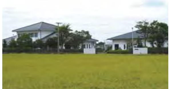
吉井浄化センター
