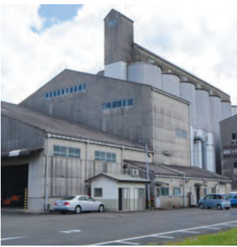
JAに吉井カントリーエレベーター
