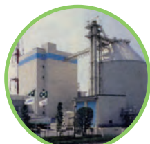
大牟田リサイクル発電所
