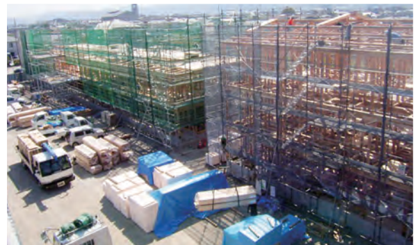
建設が進む新治団地
