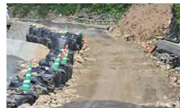
道路応急工事 県道朝田日田線(田籠)
