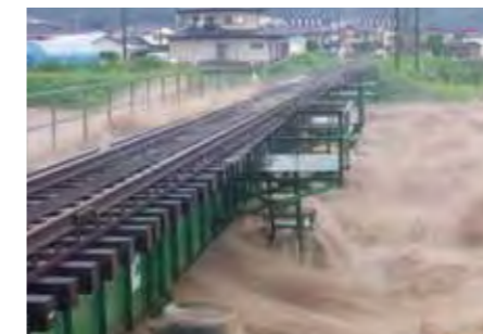
JR久大本線橋梁(西隈上)
