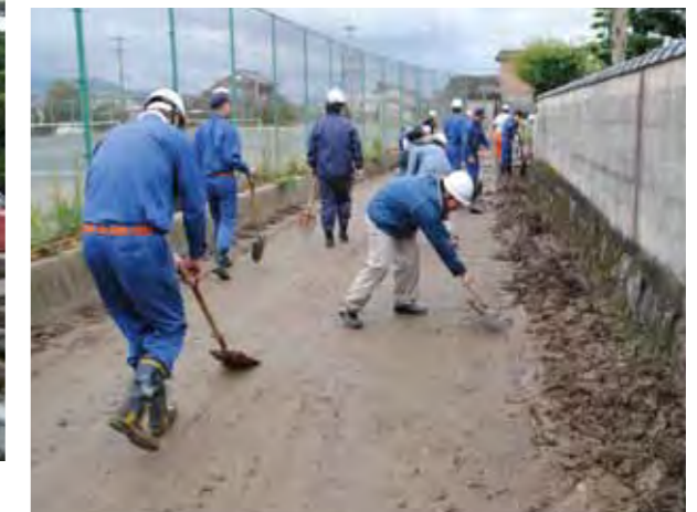
道路土砂撤去作業
