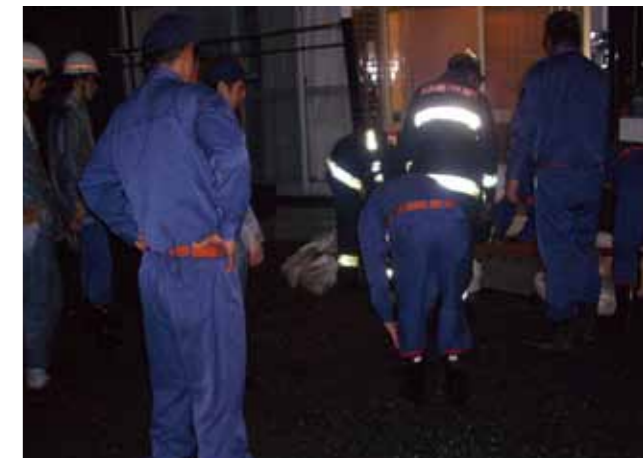
土のう積みによる浸水防止
