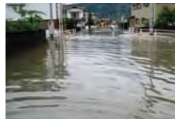
②道路冠水(県道保木吉井線 若宮)
