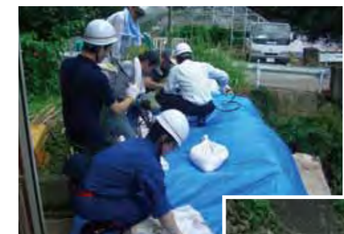
被害家屋の応急処置
